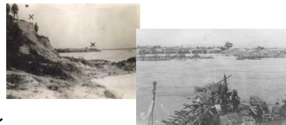
大塚切れと、復旧工事
